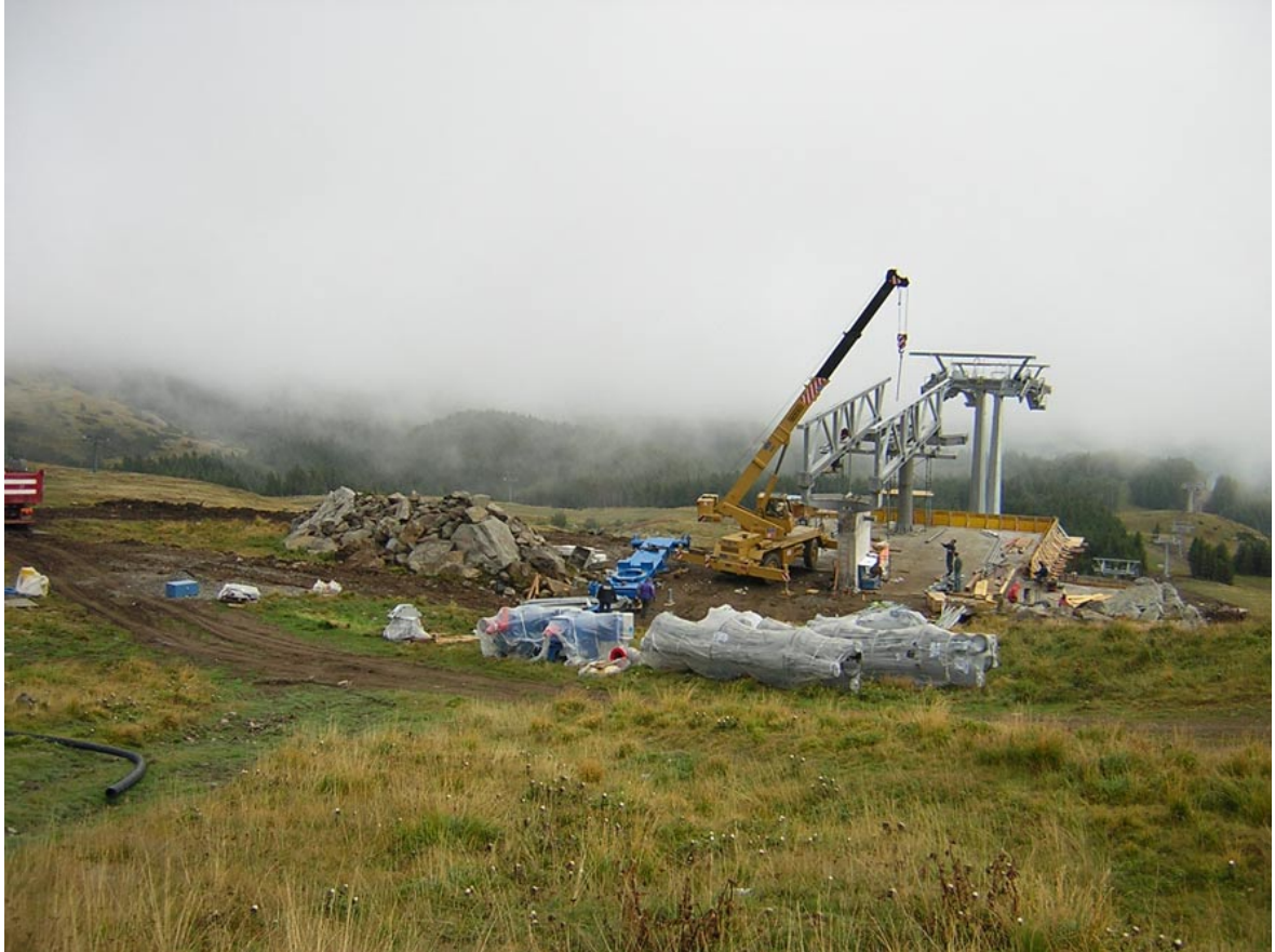
Fig. 50 - Cantiere per la costruzione della seggiovia sul Cimoncino
